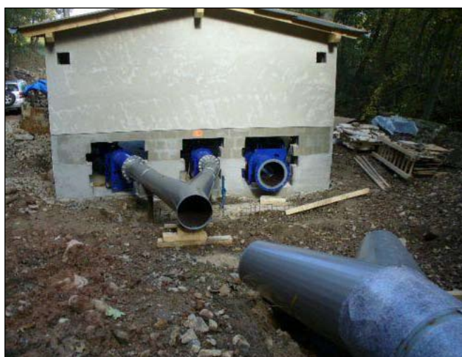
Rekonstrukce malé vodní elektrárny
